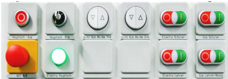
Abb. 18 Tableau mit Trenneinrichtung
