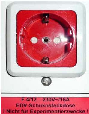
Abb. 19 gekennzeichnete Steckdose
